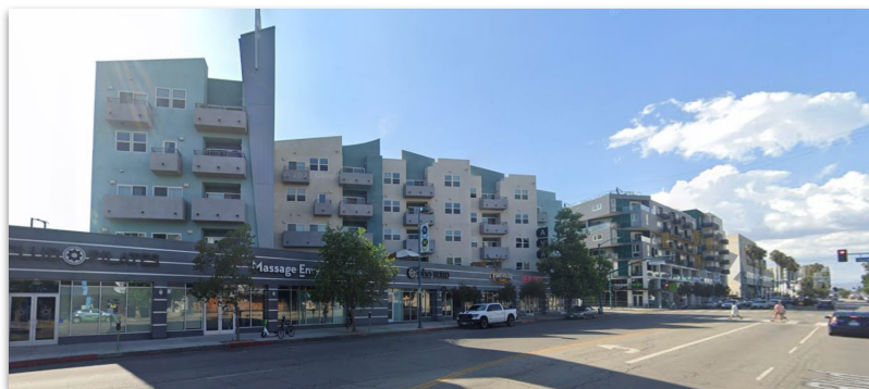
Lankershim Blvd, Google Maps Localizado en los Corredores de Oportunidad 1 y 3
